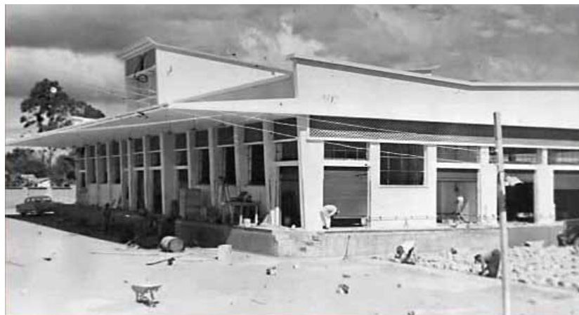
Construção da atual usina, foto de 1957
